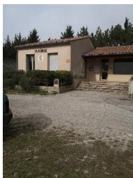
1. Réfection des toits : partie avant, au sud
