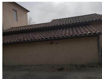
2. Réfection des toits : partie arrière, au nord
